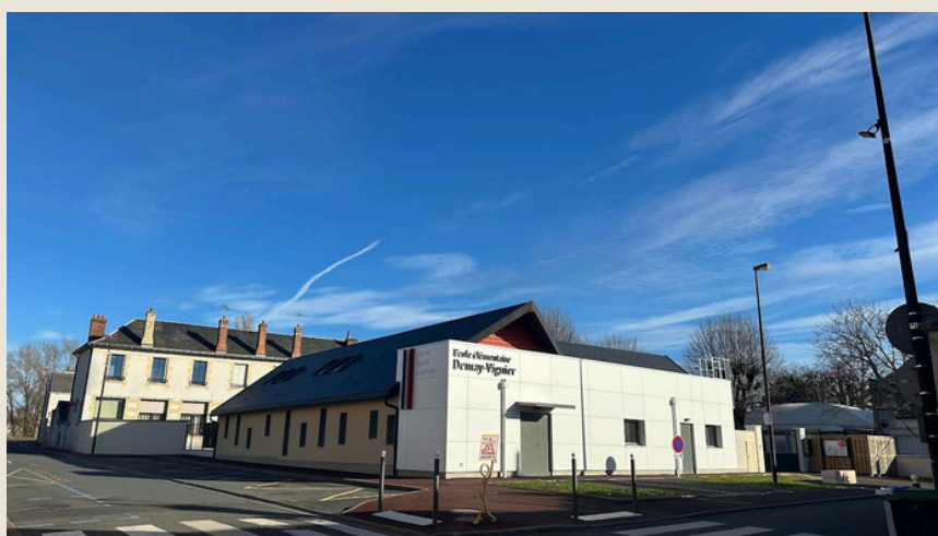
Exemple : restaurant scolaire de la commune
