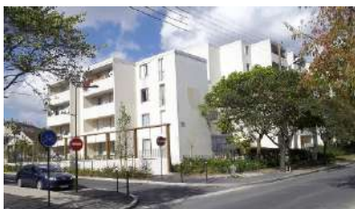
Fig.140 - Logements sociaux collectifs réhabilités au sein du quartier de l'Argonne, Orléans
