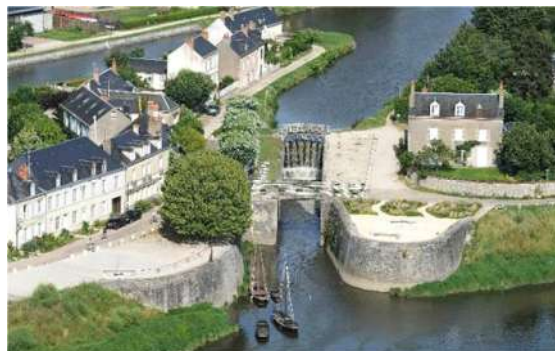
Fig.106 - L'embouchure du Canal, Combleux Source : Orléans Métropole
