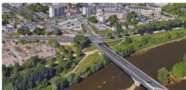
Fig.51 - Le site de la Tête Nord du pont de l'Europe
