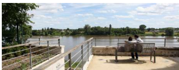
Fig.52 - Réalisation d'une promenade en belvédère sur la Loire
