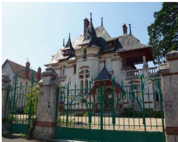
Fig.114 - Clos des Moulins « villa Debienne », rue du Maréchal Leclerc, Chécy Source : Espace Ville
