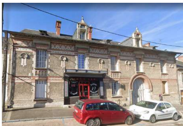
Fig.108 - 472 avenue du Pont aux Moines, Mardié Source : Google
