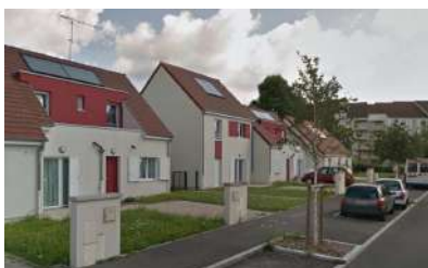
Fig.141 - Logements sociaux individuels à proximité de la gare des Aubrais, Fleury-les-Aubrais
