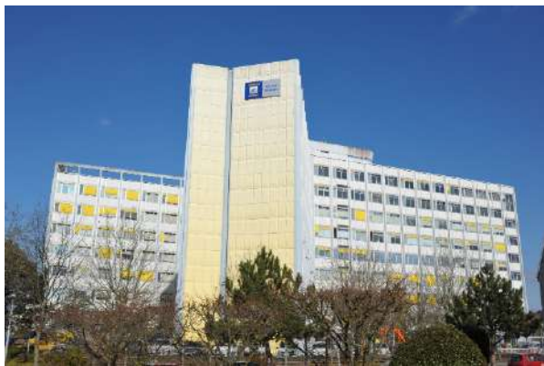
Fig.119 - Bâtiment des Postes, Orléans-La
