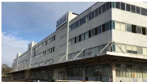
Fig.57 - Le site Quelle à l'abandon Source : Radio France
