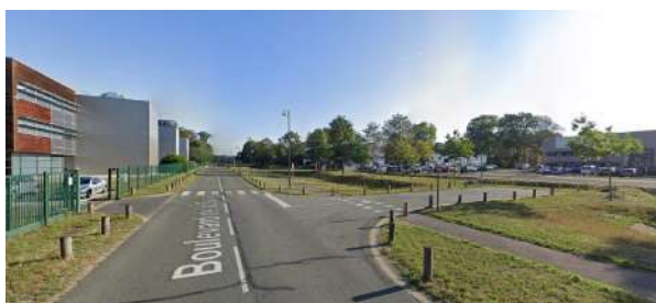
Fig. 41 – Le pôle technologique Orléans-Charbonnière, Boigny-sur-Bionne
