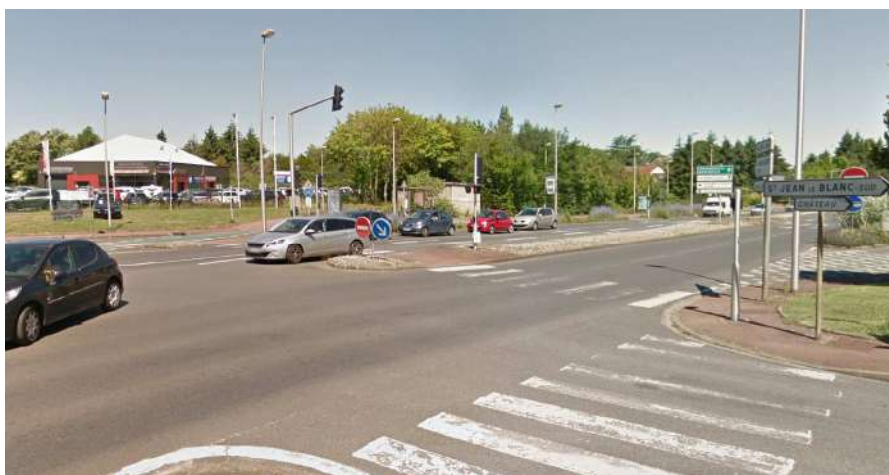
Fig.81 - L'avenue Gaston Galloux, rupture physique routière, Saint-Jean-le-Blanc Source : Google Street View
