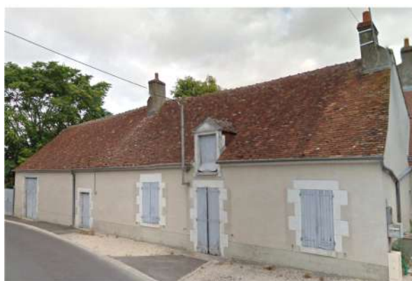
Fig.28 - Ferme, rue de Changelin, Ingré Source : Google Street View
