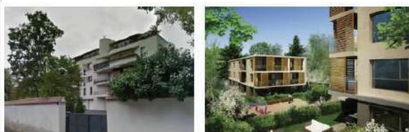
Logements collectifs – rue du Port Saint Loup – Source : Google maps Exemple de petits collectifs
