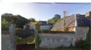
Patrimoine remarquable - rue de Grenouilly
