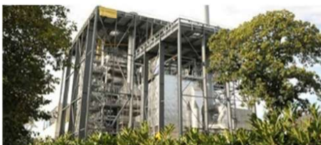
Chaufferie biomasse à La Source – Source : Orléans Métropole
