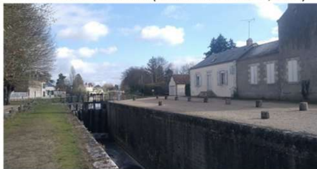
Canal d'Orléans et aménagements hydrauliques à Combleux (source : Even conseil, 2019)
